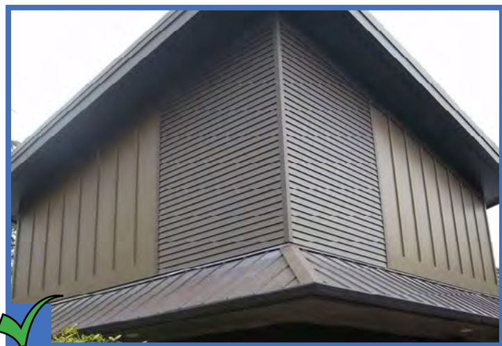
Okładziny z płyt cementowych są produkowane w różnych wersjach, o różnym wyglądzie i są dobrym materiałem o znacznym stopniu odporności na warunki atmosferyczne.
